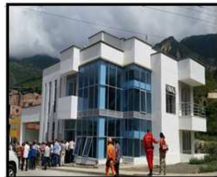
Estación de Salvamento Minero en Marmato-
