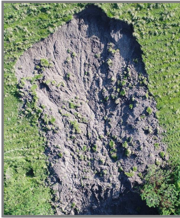
Figura 18. Deslizamiento al borde de la vía, se puede observar erosión en surcos en el movimiento. Fuente: JEDEGER.
