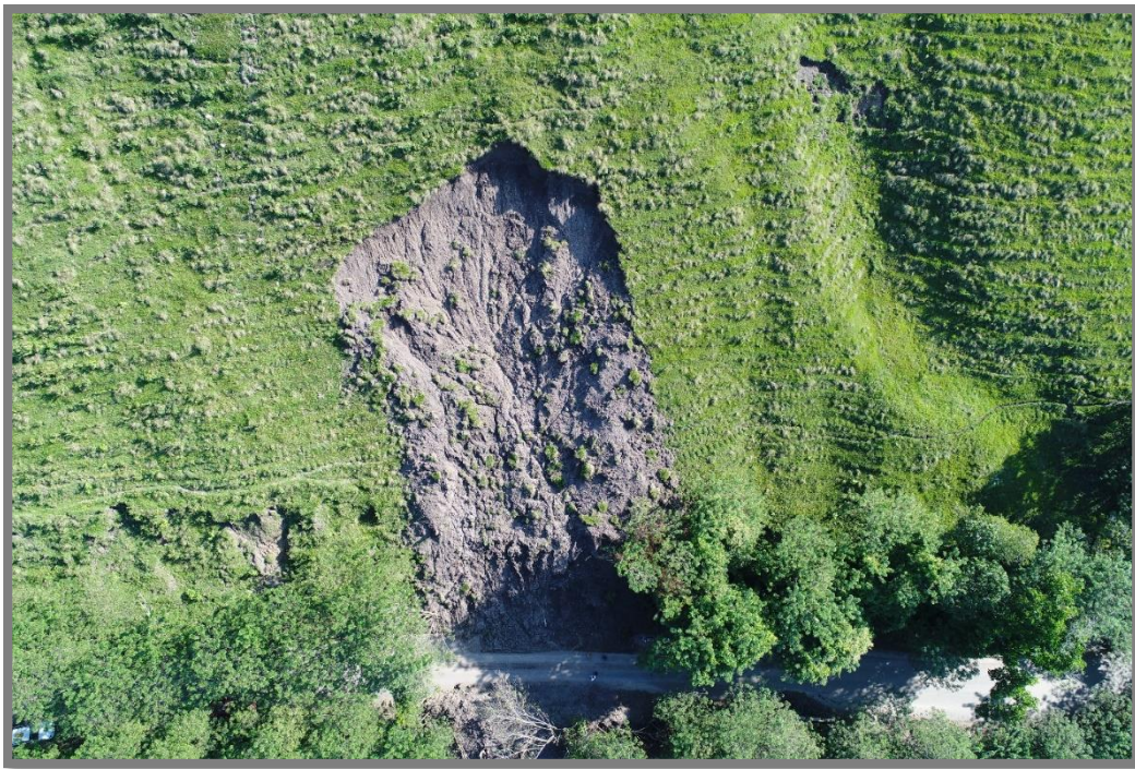
Figura 23. Movimiento en masa clasificado como un deslizamiento de tipo compuesto, el cual es el principal movimiento que amenaza la vía. Nótese la erosión en surcos dentro del movimiento. Fuente: JEDEGER.
